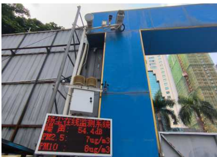
出入口视频监控
