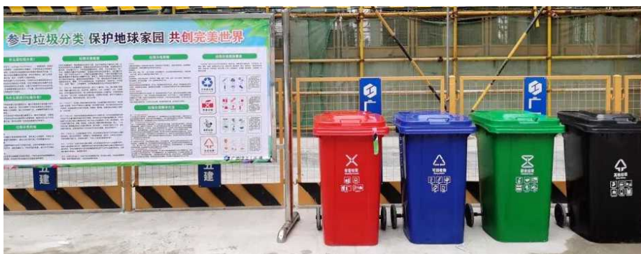
施工现场生活垃圾分类
