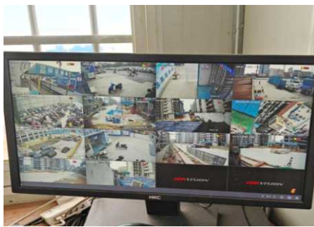
监控设备运行
