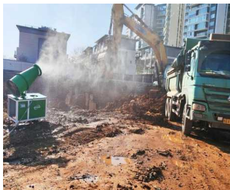
挖掘区域雾炮机喷淋覆盖
