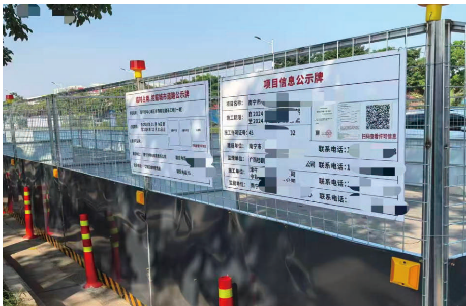
市政临时围挡现场设置
